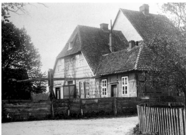
Oben: Blick von Osten zum Pfarrhof um 1900. Rechts der nachträglich angebaute Konfirmandensaal; das Dielentor im Giebel ist bereits durch eine Tür mit Vorbau ersetzt worden.
