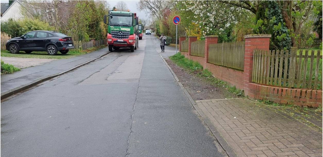
Abbildung 5: Fehlende und nicht ausreichend breite und schadhafte Gehwege in der Straße Im Tale
