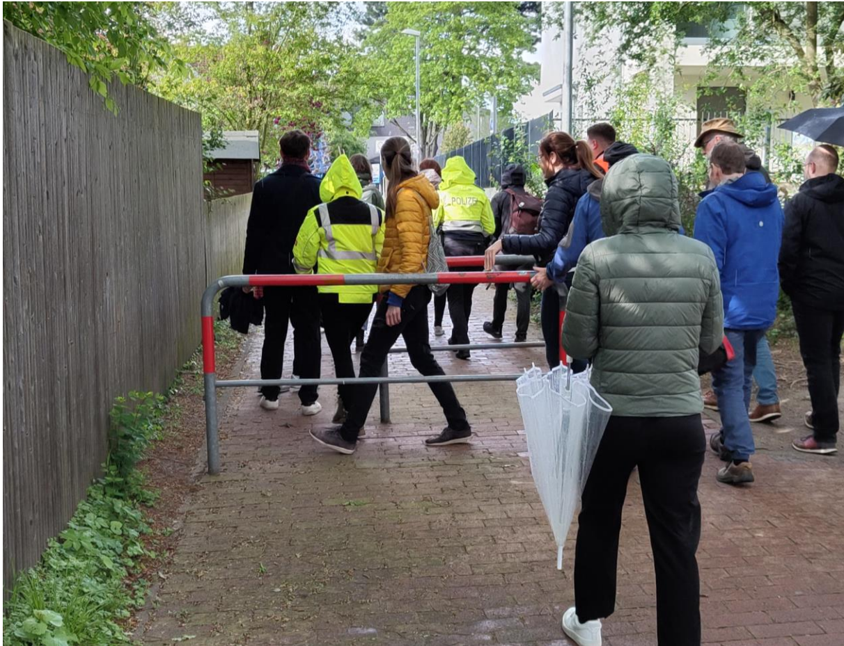
Abbildung 6: Bestandsaufnahme Umlaufsperrung gegenüber der Grundschule Harenberg
