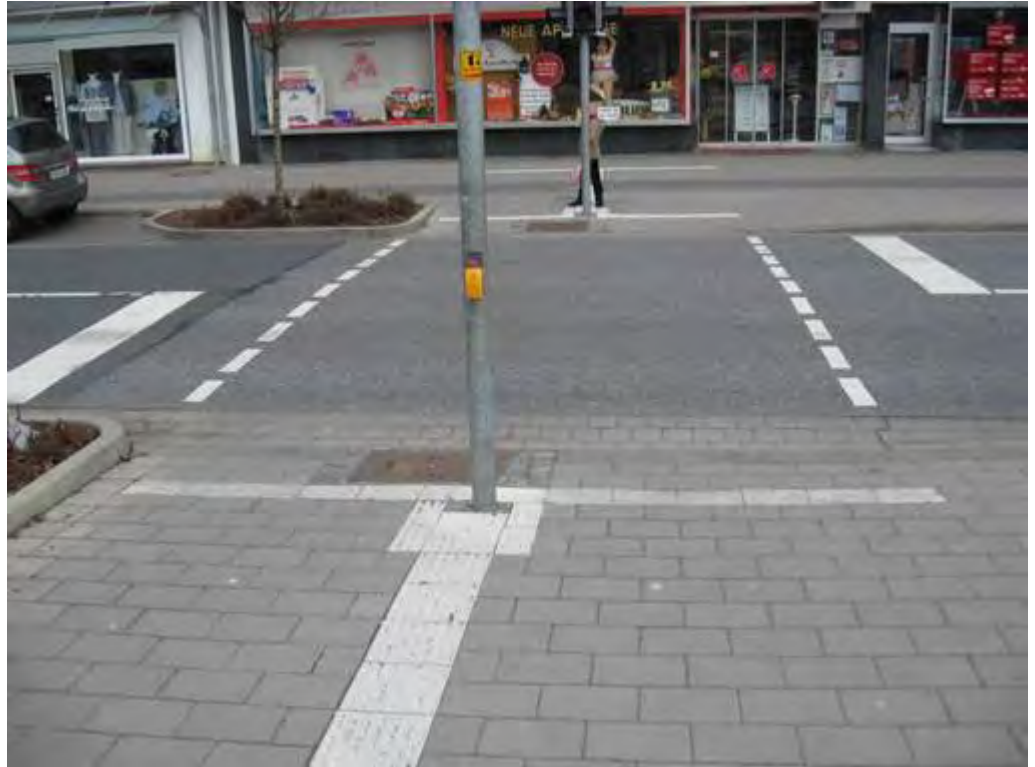
Abb. 57 Beispiel für taktile Leiteinrichtungen an einer Querungsstelle im Zuge der umgestalteten Lange-Feld-Straße (K 356) in Letter
