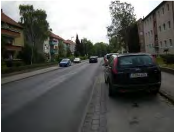
Hannoversche Straße östlich der Beethovenstraße (Blick Richtung Osten)
