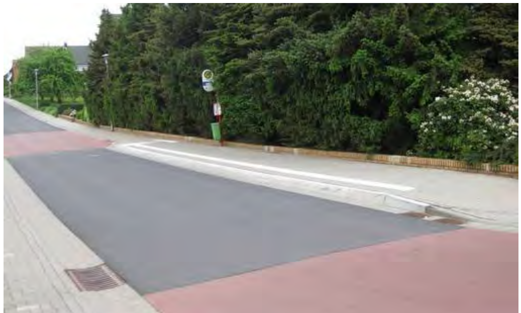
Abb. 56 Beispiel für eine barrierefrei umgestaltete Haltestelle
