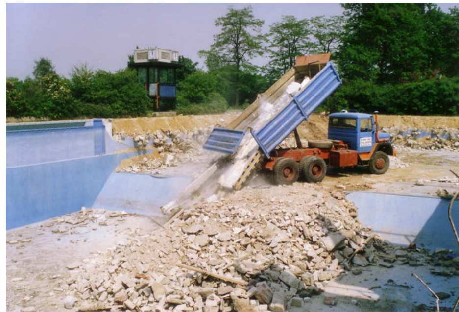
Das Schwimmerbecken des Freibades auf der Junkernwiese wird 1989 mit Bauschutt verfüllt.
