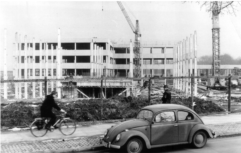
Die Baustelle der Hauptschule 1969 (Blick von der Straße An der Junkernwiese).
