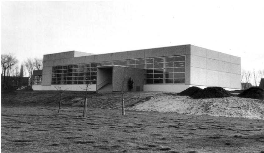
Blick von der Junkernwiese auf das neue Hallenbad. Hier sieht man, dass für das Gebäude am Wehrberg Boden aufgeschüttet werden musste.
